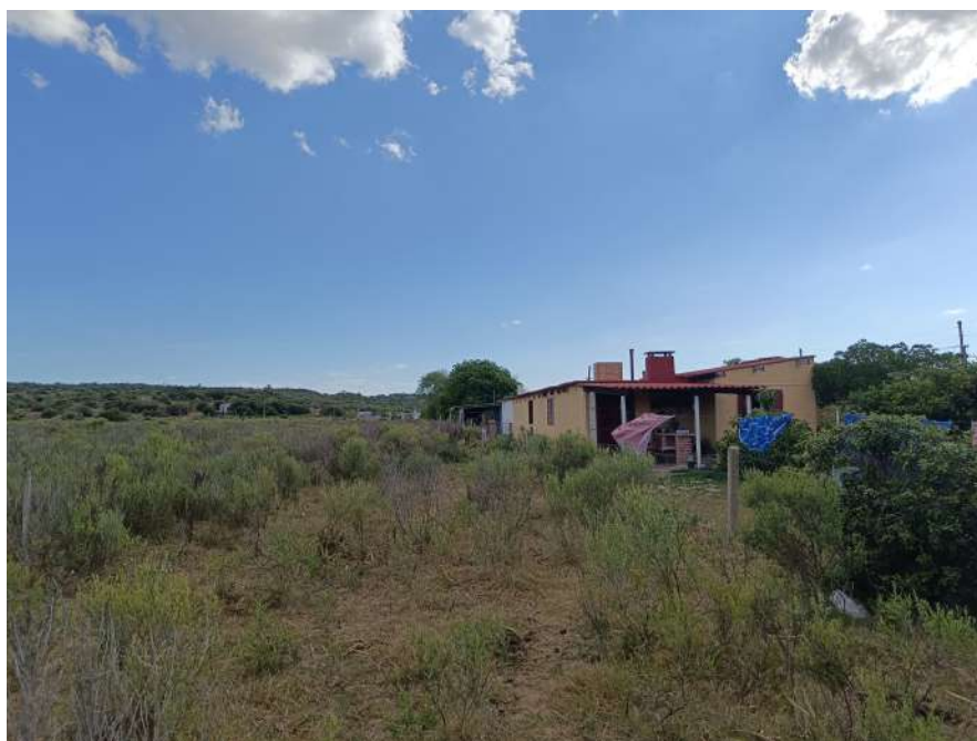
Figura 5-1. Construcciones en el lindero Oeste.
